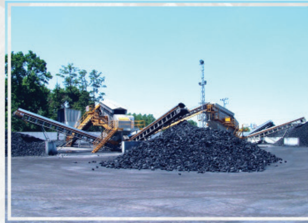
KÖMÜR ELEME ve SINIFLANDIRMA TESİSLERİ
